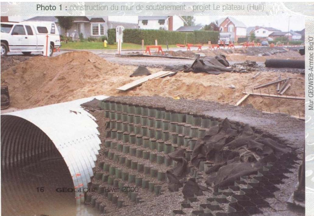
Mur GEOWEB-Armtec Big'O'
