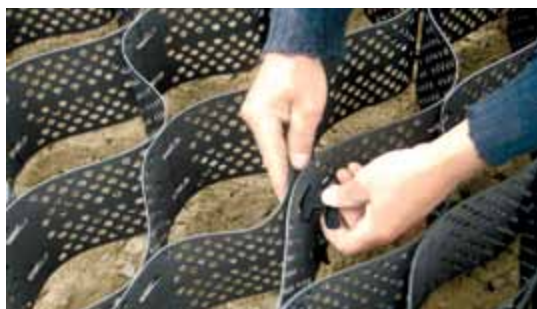
Conexión de las secciones de GEOWEB® con llaves ATRA®.
