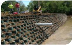
**4 Los muros de gravedad no necesitan refuerzo.**
