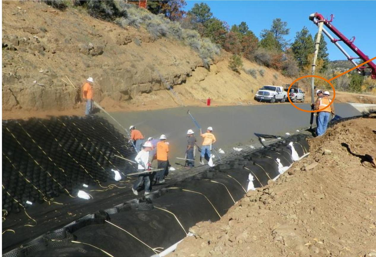
**5 Geoweb permite un concreto con asentamiento alto.**
