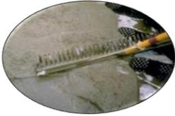
**2** Geoweb® permite un concreto con asentamiento alto.
