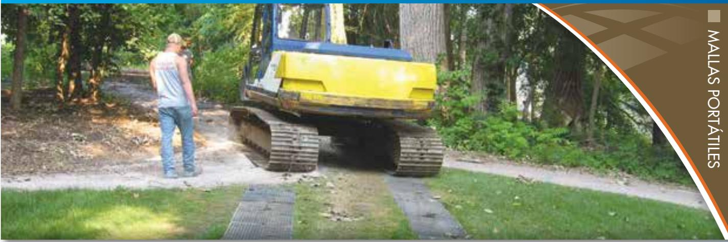
Las **mallas de protección para la superficie GEORUNNER®** son mallas para construcción portátiles, económicas y fáciles de transportar. Su peso liviano (8 lb/3,6 kg) y su tamaño fácil de manejar las hace ideales para su transporte y colocación en emplazamientos de construcción.
