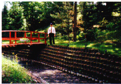
En regardant le lit amélioré du ruisseau Leamy, on distingue le système de revêtement.
