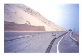
Para habilitar el pase de una densidad de vehículos detenidos por el estado en que quedó la Panamericana Sur, se tuvo que ensanchar la vía en ciertos puntos identificados, entre ellos en el km 731. Se retiró uno de los muros construídos para dar pase al ensanchamiento, se pudo rescatar una cantidad determinada de secciones de geoweb las cuales fueron guardadas para una aplicación posterior.
