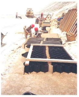
Oueda claro que la estructura es de una naturaleza muy drenante y de flexibilidad por lo que no es necesario un sistema paralelo de drenaje, ni tampoco el uso de juntas
