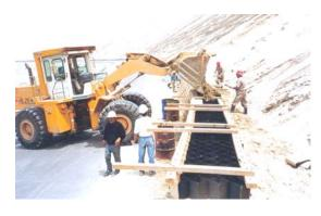
El muro está conformado de un material similar al medio, consistente en arena, tal que su comportamiento frente a solicitaciones sísmicas, pueda ser más uniforme que cualquier otro tipo de estructura tradicional.
