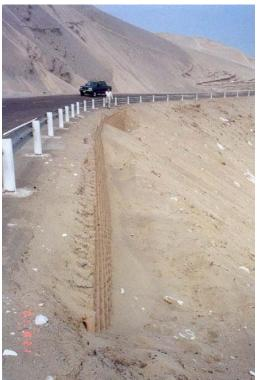
Las fotografía presentada corresponde a un muro ubicado al lado derecho bajo las guardavías, y permanece hasta la actualidad. Varios de estos muros en este sector son un ejemplo de las ventajas de trabajar con el Confinamiento Sistema de Geocelular GEOWEB.
