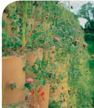
Los muros GEOWEB® son altamente permeables y actúan como una gran cantidad de macetas de siembra, lo que permite que el agua de lluvia se infiltre a través de la pared, minimizando la escorrentía.
