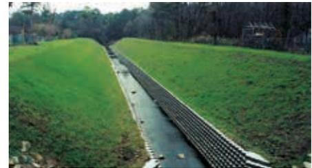
Las celdas de la fascia GEOWEB® llenas de agregado o lechada resisten caudales más altos y continuos.
