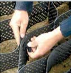
Para una conexión fácil y rápida de las secciones GEOWEB®, las ATRA keys exclusivas reducen significativamente el tiempo de instalación del contratista y proporcionan una conexión 3 veces más fuerte de las secciones GEOWEB® que cualquier otro método. Hecho de polímero resistente a la corrosión.
