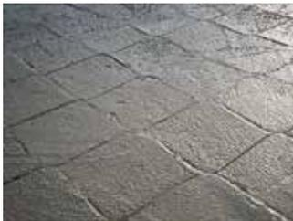
La protección de talud con GEOWEB® con relleno de concreto brinda una protección económica y endurecida de taludes expuestos a fuertes esfuerzos hidráulicos o mecánicos. La calidad, el acabado de la superficie y el espesor del concreto se pueden seleccionar para cumplir con las necesidades de diseño específicas.
