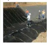
Los ATRA® Tendon Clips de Presto hacen una conexión segura con la pared celular GEOWEB® para la transferencia de cargas desde el tendón a la pared de celda.
