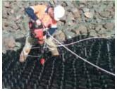
Los Anclajes ATRA® de Presto establecen una conexión segura con la pared celular del GEOWEB® y son rápidos y fáciles de instalar con Clavadores ATRA®.
