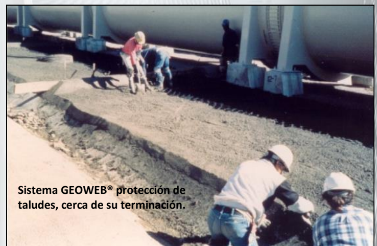
Colocar hormigón en el sistema GEOWEB®
